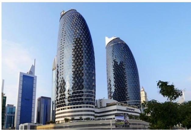
Εικόνα 5. Το έργο «Park Towers» στο Dubai. Υλοποίηση παραμετρικών Κωδίκων G για τις κοπές των προφίλ αλουμινίου σε 5-αξονικό κέντρο κατεργασιών.
